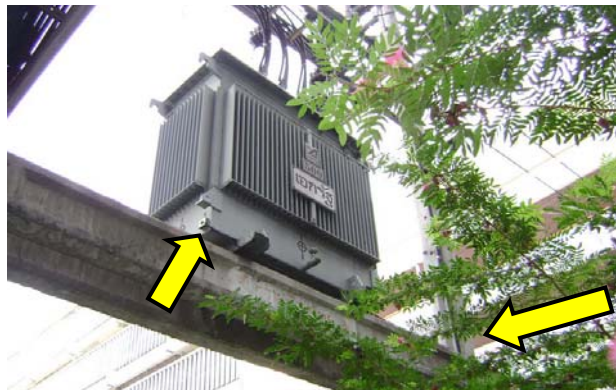
รูปที่ 5 การต่อลงดินของตัวถังหม้อแปลงไฟฟ้าที่เสาต้าน HT Meter
