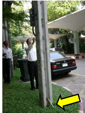
รูปที่ 4 การต่อลงดินของตู้เครื่องวัดหน่วยไฟฟ้าแรงสูง
