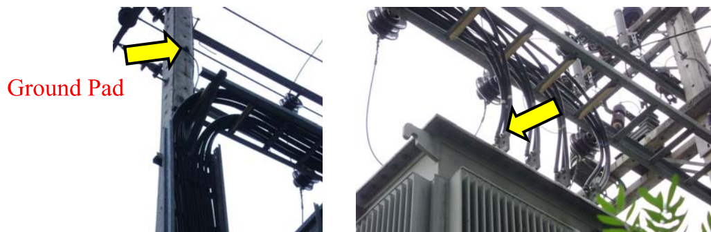
รูปที่ 6 การต่อลงดินของนิวทรัลของหม้อแปลงไฟฟ้า
