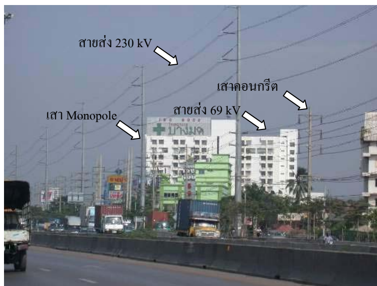
รูปที่ 2 ภาพถ่ายรูปแบบการติดตั้งของสายส่งอากาศ 69 / 230 kV
