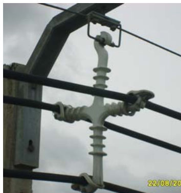
รูปที่ 10 ภาพการติดตั้งตัวแยกสายไฟฟ้าที่ผ่านการปรับปรุงมาแล้ว
