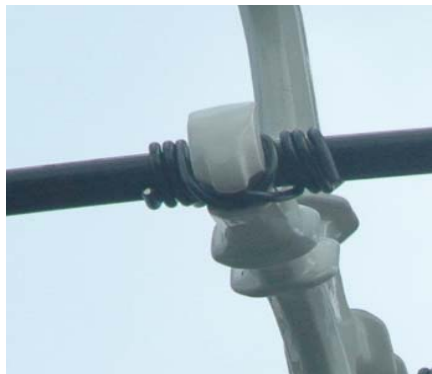
รูปที่ 7 สายรัดแบบ Aluminum Tie Wire หุ้มฉนวน
