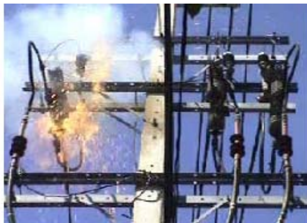
รูปที่ 3 กัับดักฟ้าผ่าระเบิดขณะสับครี้อุปฟิวส์
